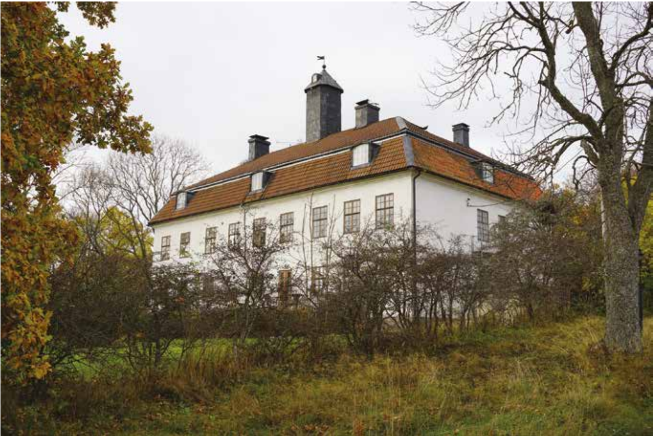
Ludvigsberg, södra fasaden, hösten 2015. Foto: Tobias Mårud.
