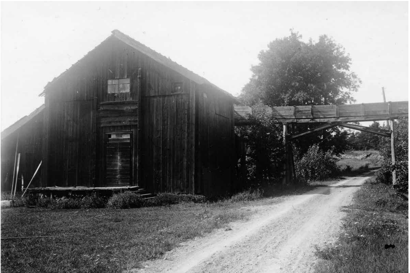
Lättinge kvarn med trärännan som leder vattnet, 1939 Foto: Nordiska museet, Ragnar Jirlow
