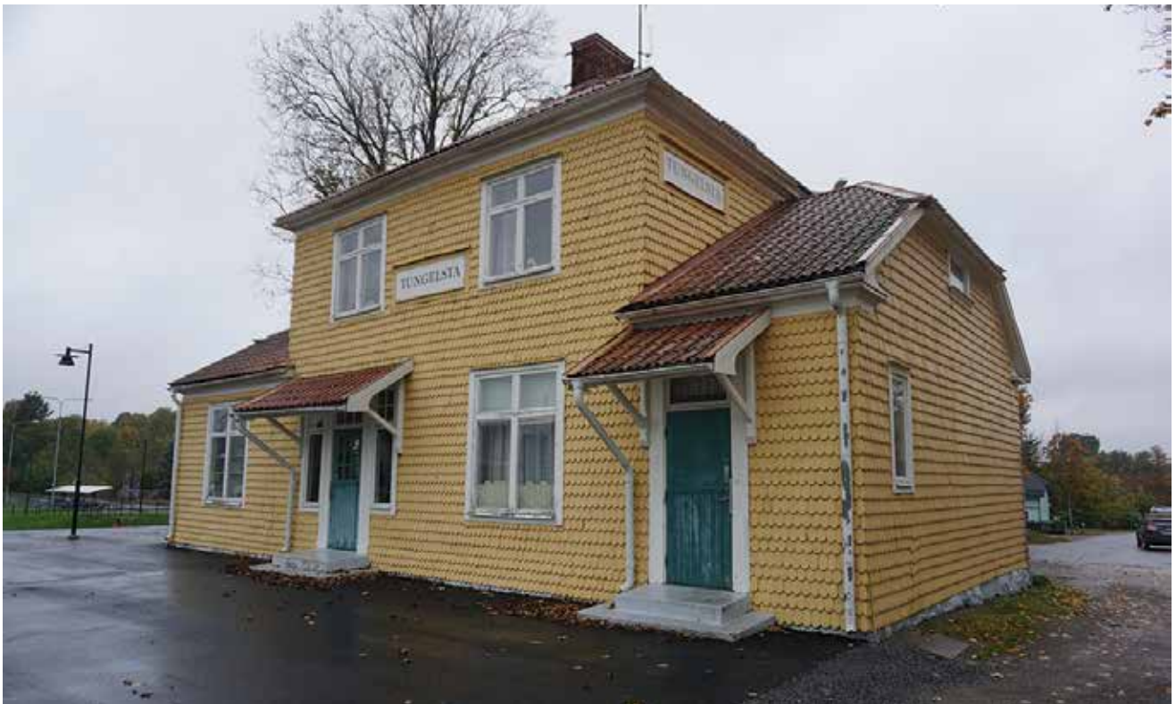
Tungelsta stationshus som ritades av Ferdinand Boberg. Byggnaden karaktäriseras av spånklädda fasader och de två lägre byggnadskropparna vid sidan om mittpartiet. Byggande är utpekad och beskrivs närmare i kulturmiljöinventeringen - Tungelsta. Foto Haninge kommun
