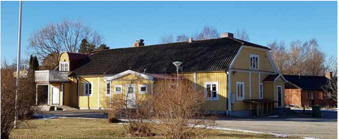
Västerhaninge bygdegård uppfördes av Bondeförbundets lokalavdelning år 1929 längs med gamla landsvägen, ca 250 meter om kyrkan. Byggande är utpekad och beskrivs närmare i kulturmiljöinventeringen - Västerhaninge. Foto Haninge kommun
