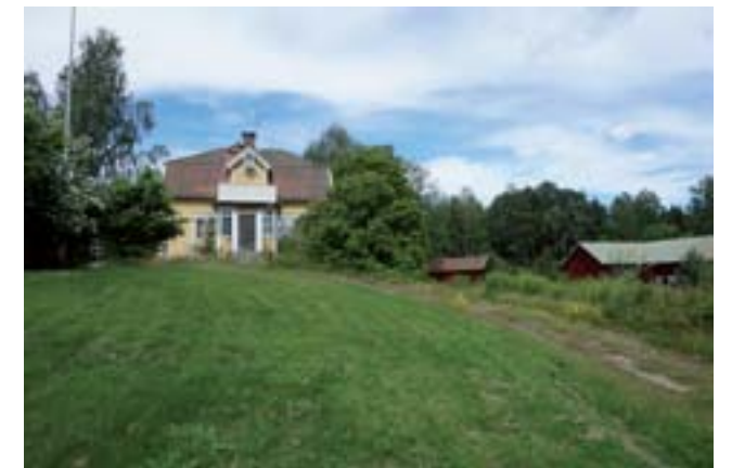
Manbyggnad, i 1 ½ våning, delvis i suterräng, på gjuten grundmur. Halvvalmat mansardtak, tvåkupigt lertegel, gulmålad locklistpanel, vitmålade detaljer som fönster, omfattningar, knutbrädor, vindskivor m.m., förstuga med ovanpå liggande balkong och frontespis, liten utbyggnad mot norr med köksentré, burspråk mot väster. Manbyggnaden är uppförd 1927, på samma plats som det tidigare bostadshuset. Foto: Tobias Mårud.
