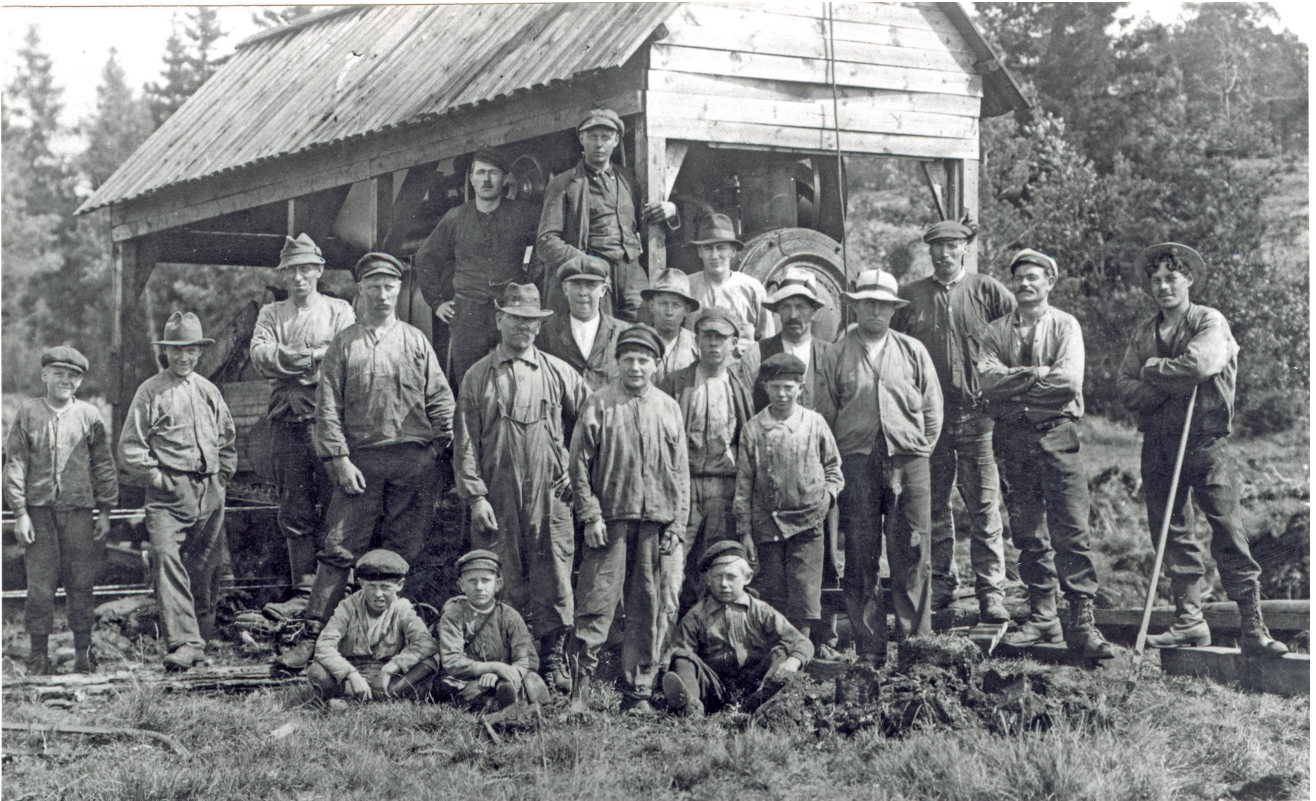
Arbetslag vid en torvupptagningsmaskin vid Slätmossen mellan Handen och Jordbro, 1919. Bakom arbetslaget syns en ångmaskin i formen av en Lokomobil inbyggd i skjulet. Den drevs av en elevator som drog upp torven från graven till en torvkvarn i en process där man rev torven och pressade samman den i lagom portioner för att därefter saltorkas. Foto: Haningearkivet.
