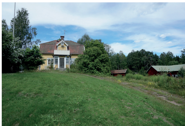
Manbyggnad, i 1 ½ våning, delvis i suterräng, på gjuten grundmur. Halvvalmat mansardtak, tvåkupigt lertegel, gulmålad locklistpanel, vitmålade detaljer som fönster, omfattningar, knutbrädor, vindskivor m.m., förstuga med ovanpå liggande balkong och frontespis, liten utbyggnad mot norr med köksentré, burspråk mot väster. Manbyggnaden är uppförd 1927, på samma plats som det tidigare bostadshuset. Foto: Tobias Mårud.
