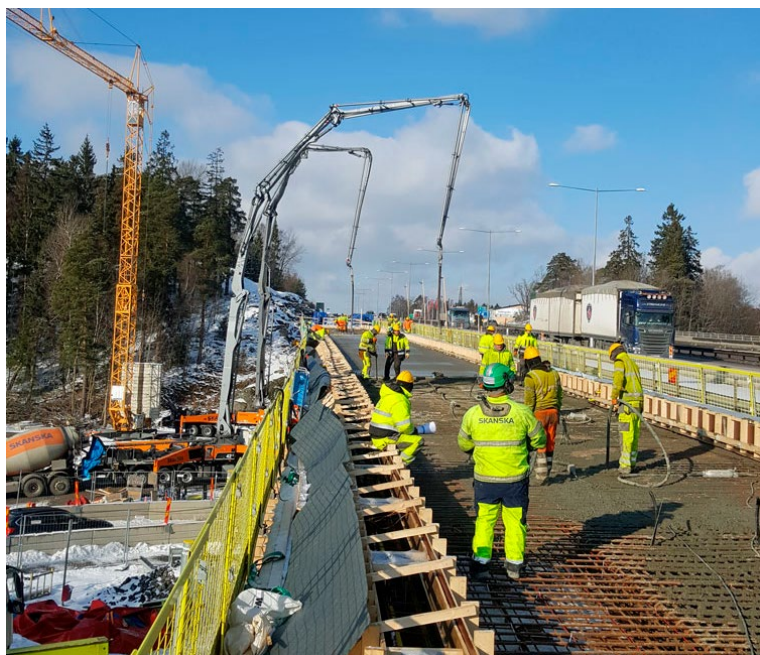
Gjutning av bro i nya Vega trafikplats.
