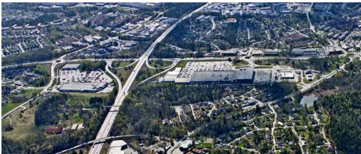
Trafikplats Handen. Österport (vid ICA Maxi) och Västerport (vid PORT73). Flygfoto: Haninge kommun, 2014.
