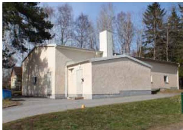
Telestationen Tungalsta. Foto: Kjell Eriksson
