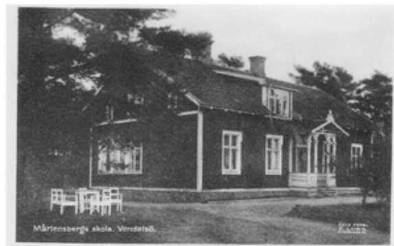
Mårtensbergs skola. Äldre vykort.
