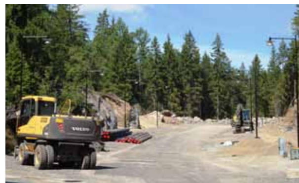
Vega allé under utbyggnad. Här pågår arbete med infarten från Hermanstorpsvägen. Foto: Mathias Rantanen, juli 2014.
