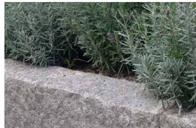
Kantstöd av råhuggen granit runt delar av planteringsytorna.
