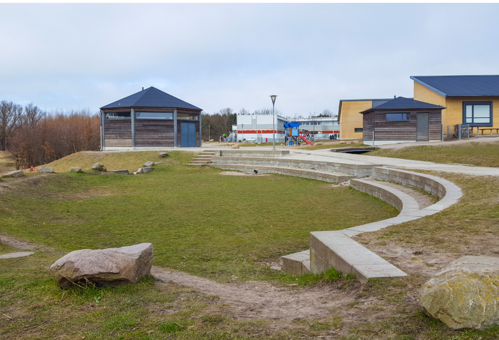
Bild 2: Multifunktionell yta intill skola där dagvatten vid skyfall tillfälligt fördröjs innan ytlig avdelning till intilliggande recipient. Under större delen av året används platsen som lekya.
