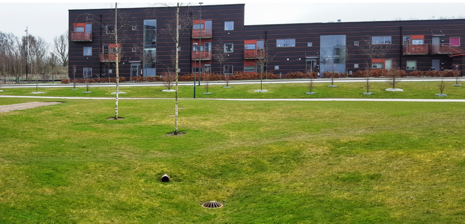
Bild 1: Omhändertagande av dagvatten på grönyta intill byggnader med kupolbrunn för bräddning.
