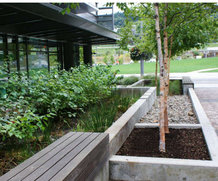
Bild 9: Fördröjning av takvatten i regnbädd över marknivå med dräneringsrör i Portland (vänster). Rening av dagvatten från väg i Tyresö, skapad i befintlig miljö med lokala, salttåliga växtarter (höger). Källa: SWECO.
