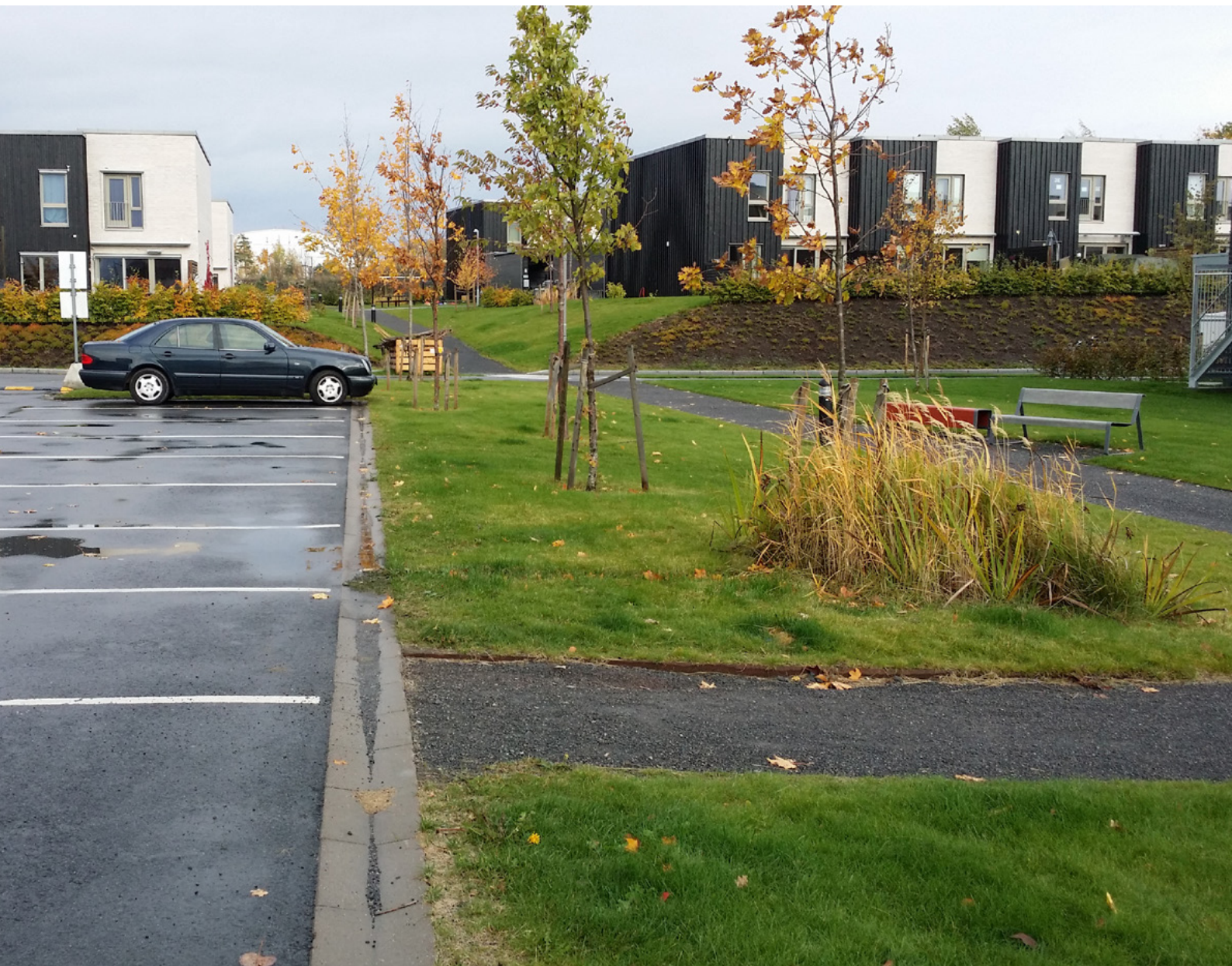
Bild 4: Biofilter med rännan intill parkering i Oslo. Källa: SWECO
