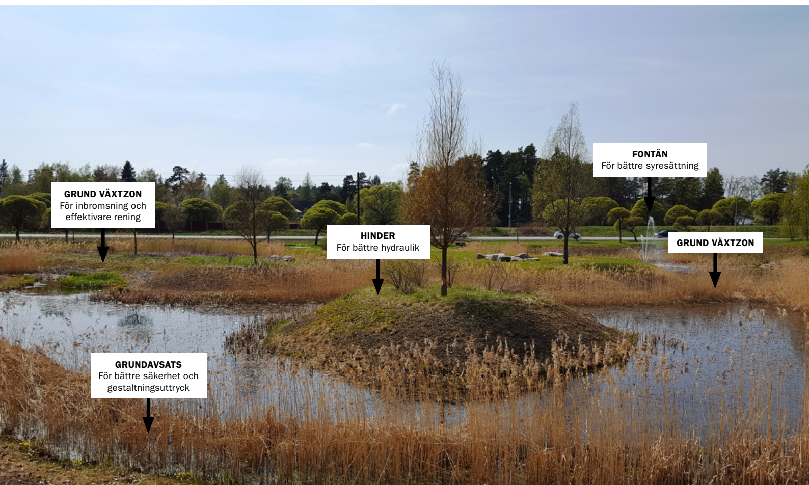
Bild 16: Damm med fast hinder, grundare vegetationshinder, grunda avsatser och fontän för extra syresättning.
