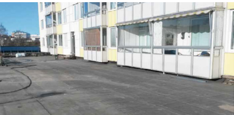
Bild 19: Renovering av gårdsbjälklag, Jönköping. Installation av tätskiktsmatta och färdig innergård. Källa: Grönatakhåndboken.
