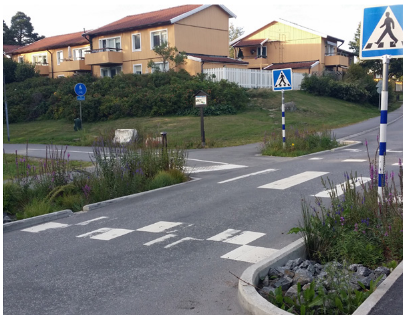
Bild 9: Fördröjning av takvatten i regnbädd över marknivå med dräneringsrör i Portland (vänster). Rening av dagvatten från väg i Tyresö, skapad i befintlig miljö med lokala, salttåliga växtarter (höger). Källa: SWECO.
