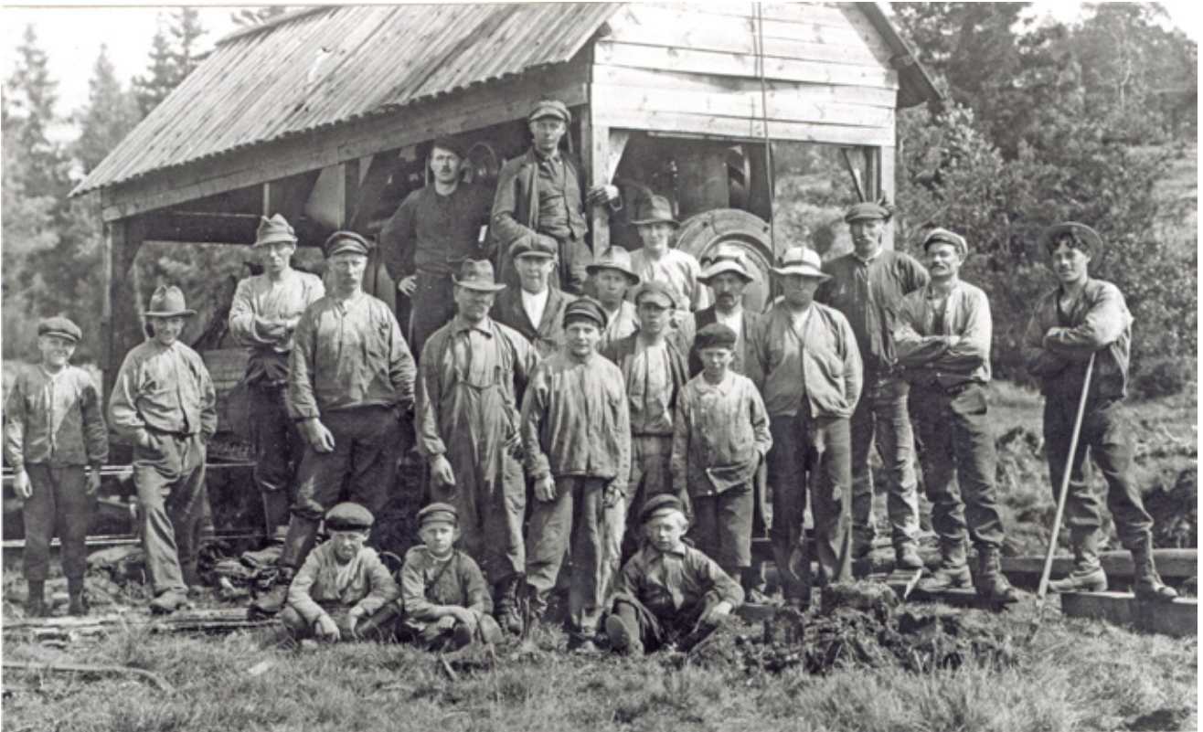
Arbetslag vid en torvupptagningsmaskin vid Slätmosen mellan Handen och Jordbro, 1919. Bakom arbetslaget syns en ångmaskin i formen av en Lokomobil inbyggd i skjulet. Den drevs av en elevator som drog upp torven från graven till en torvkvarn i en process där man rev torven och pressade samman den i lagom portioner för att därefter saltorkas. Foto: Haningearkivet.
