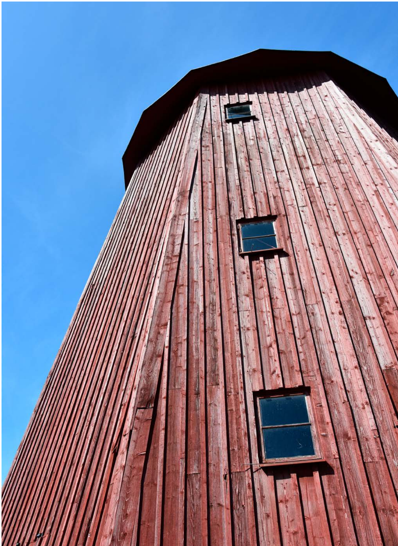
Kvarnen brann ner på grund av ett blixnedslog 1988, men återuppbyggdes två år senare i samma utförande. Här syns tydligt byggandens typiska stående locklistpanel med små enluftsfönster med enkel spröjs. Foto Moa Andersson WSP
