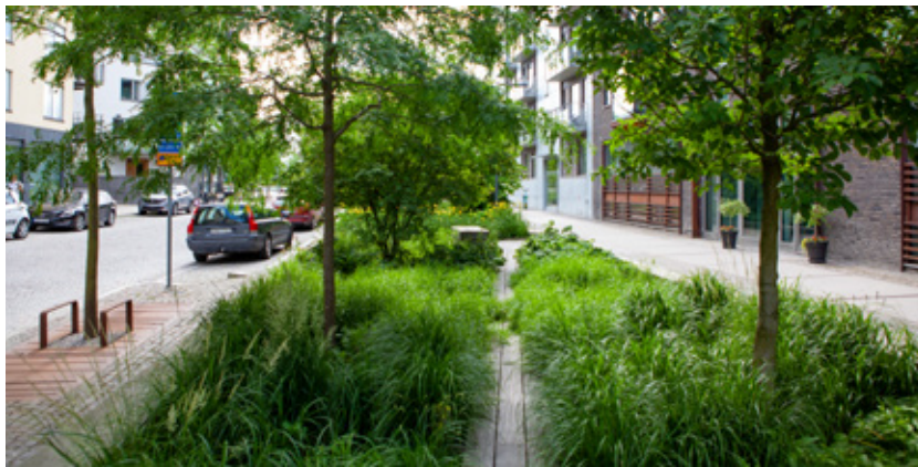
Öppen dagvattenhantering och gröstruktur i staden. Norra Djurgårdsstaden, Stockholm.
