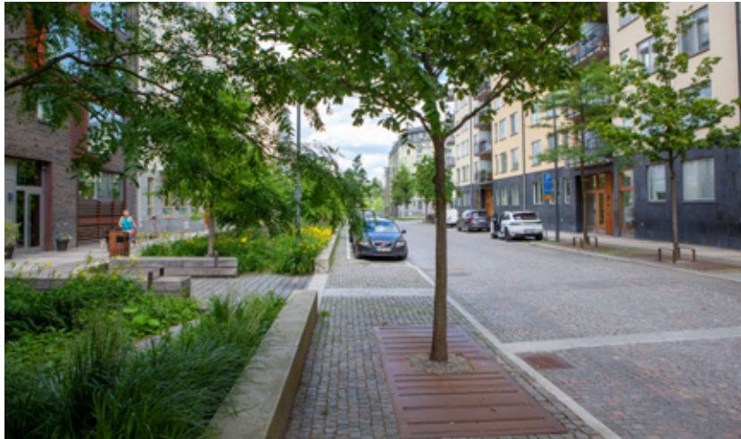
Gatuträd planterade i biokolsbäddar är en del av en systematisk dagvattenhantering och rening av gatans vatten. Norra Djurgårdsstaden, Stockholm.
