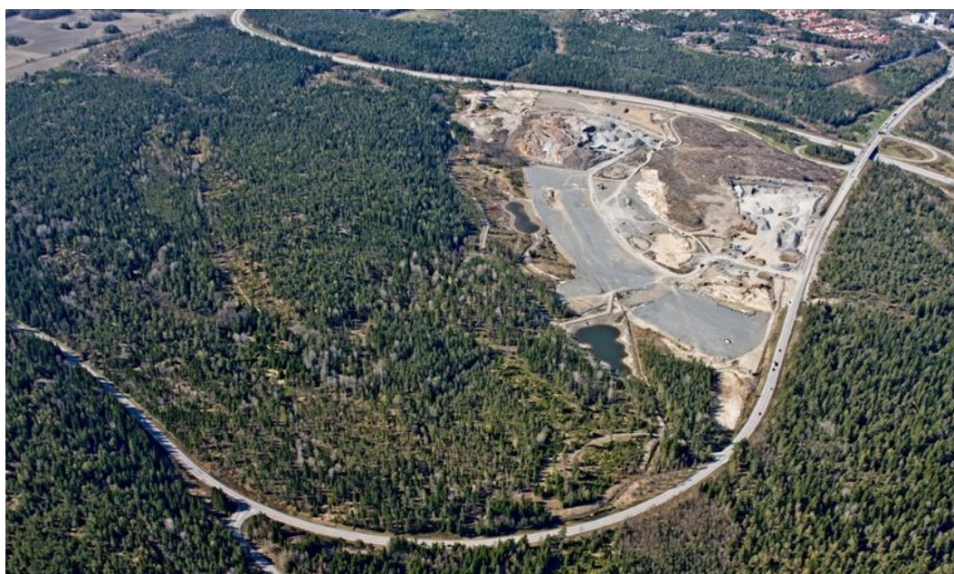
Figur 1.3. Flygfoto över Albyberg 2 (till vänster) och Albyberg 1 (till höger) samt Jordbro i bakgrunden.
