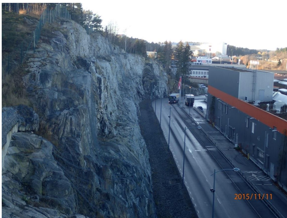
Figur 2.5. Bergslänten bakom Hornbach är uppdelad på tre pallar med avsats emellan. Bergförstärkningen består av bergbultar och skyddsnät.
