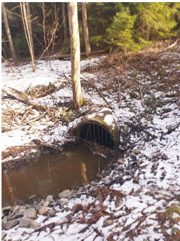
Figur 37. Bild på Åbyån och trumman som leder vattnet under Nynäsvägen och Nynäsbanan
