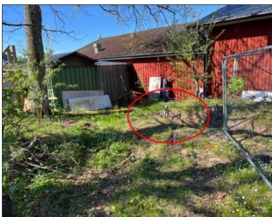
Foto 9. Manlucka till spilloljetanken är inringad med röd cirkel.
